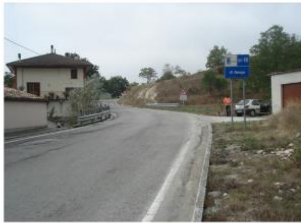
Foto n.1 – Vista dalla strada, in direzione Pergola
