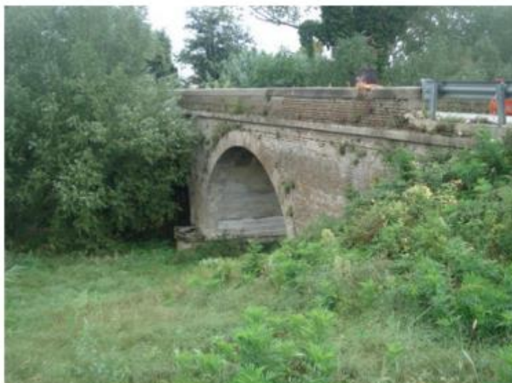
Foto n.2 – Vista laterale, lato monte
