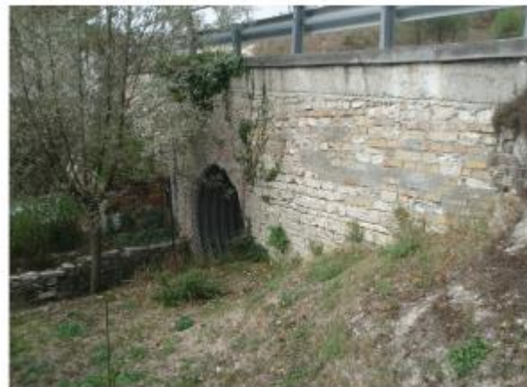
Foto n.2 – Vista laterale, lato valle
