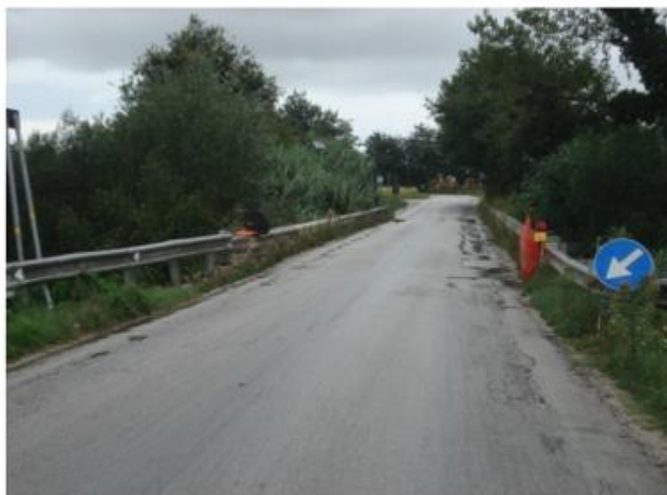
Foto n.1 – Vista dalla strada, in direzione Montemarciano
