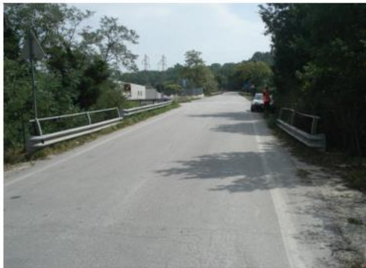
Foto n.1 – Vista dalla strada, in direzione Albosola
