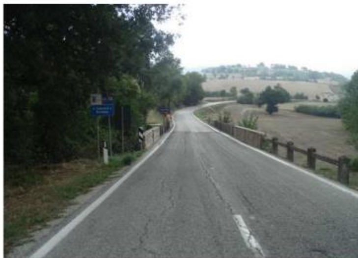
Foto n.1 – Vista dalla strada, in direzione Pergola
