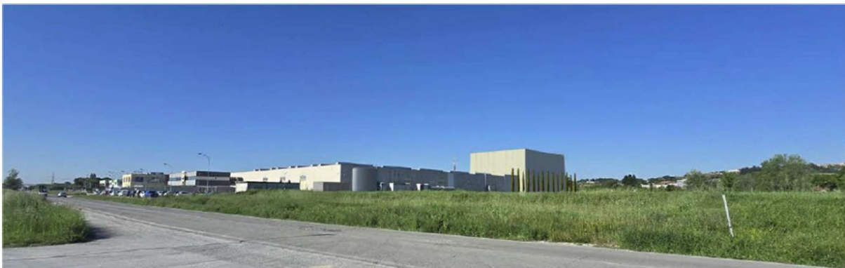
Vista del lotto EUROCOM dalla strada che costeggia l'area produttiva – Stato di progetto
