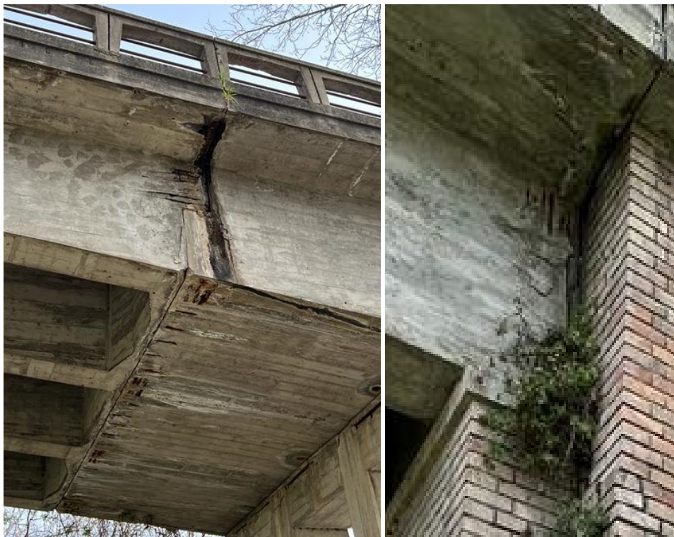
Figura 3.1 - Degrado in corrispondenza delle selle Gerber e dei traversi di spalla
