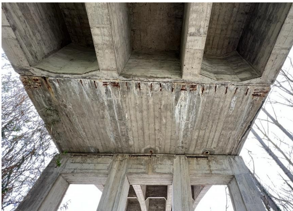
Figura 3.2 - Degrado in corrispondenza della sommità delle pile
