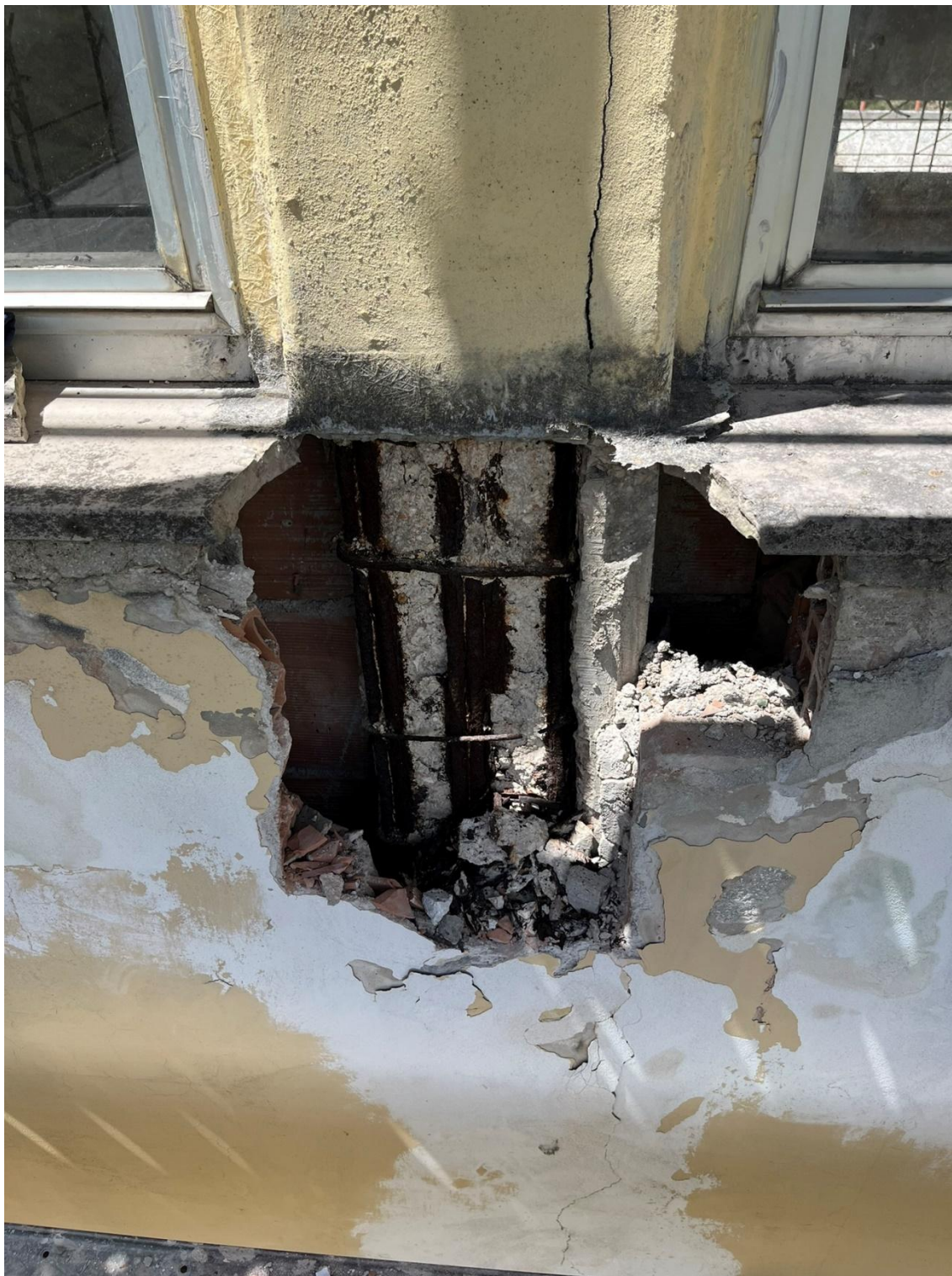
Foto 1 – ammaloramento pilastro
