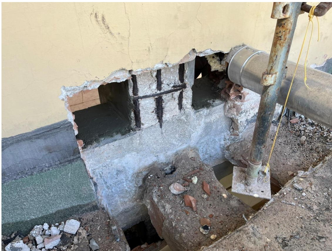
Foto 2 – ammaloramento pilastro
