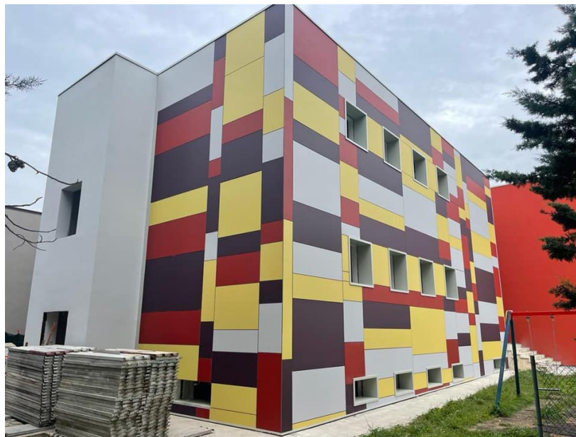
Foto di cantiere durante i lavori
