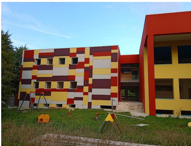
Foto di cantiere durante i lavori
