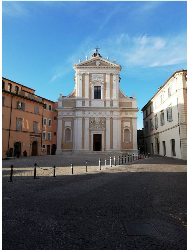
Facciata restaurata Collegiata San Giovanni
