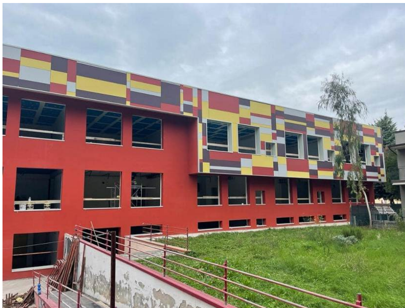
Foto di cantiere durante i lavori
